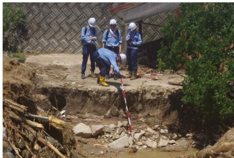
被災状況調査
