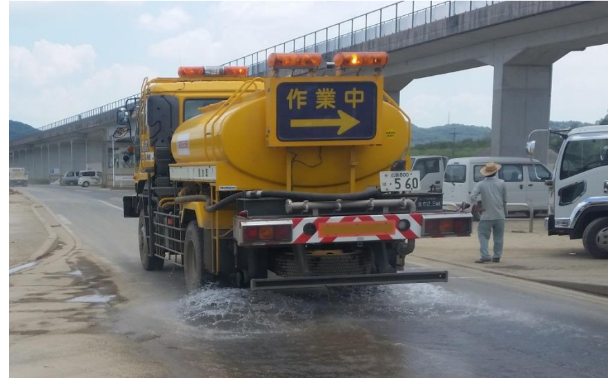
散水作業（倉敷市真備町）
