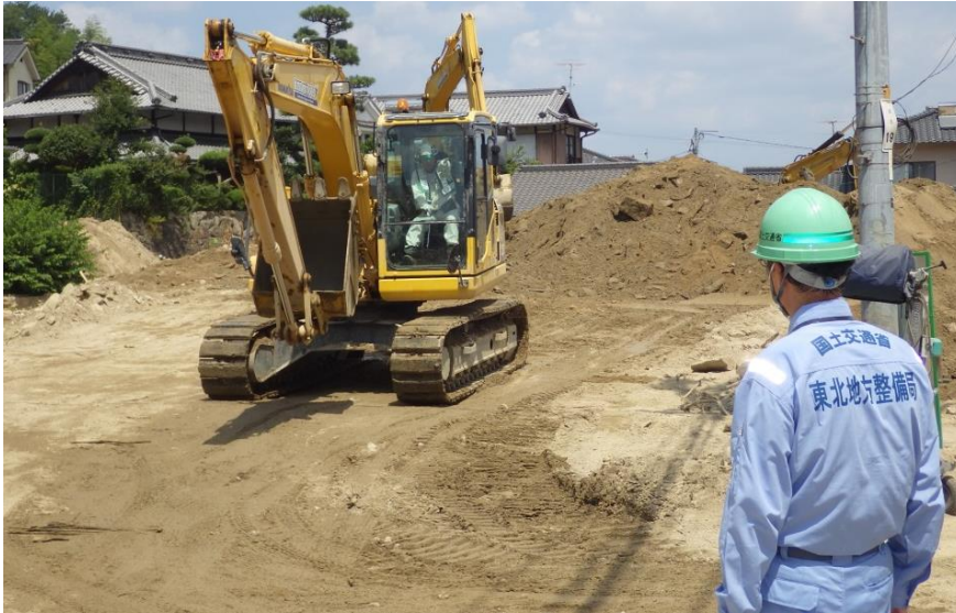
現地状況確認（坂町坂西）
