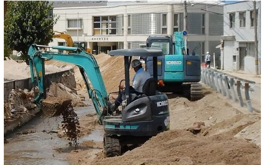
土砂撤去作業（坂町坂西）
