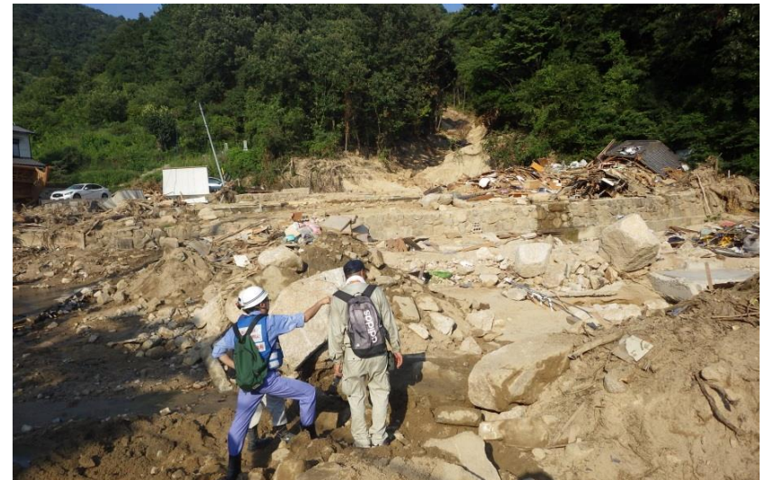
現地状況確認（呉市天応町）
