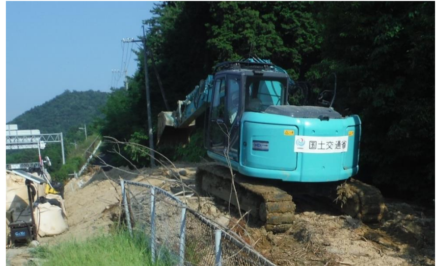
土砂撤去作業（東広島市高屋町）
