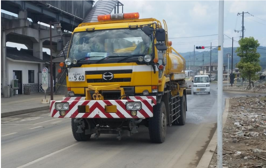
散水作業（倉敷市真備町）
