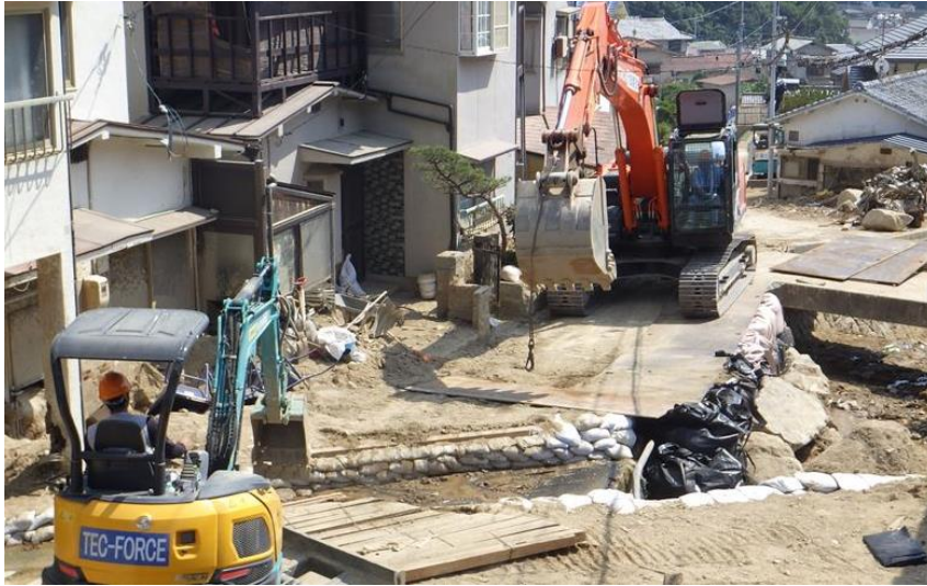
道路啓開作業（呉市天応町）
