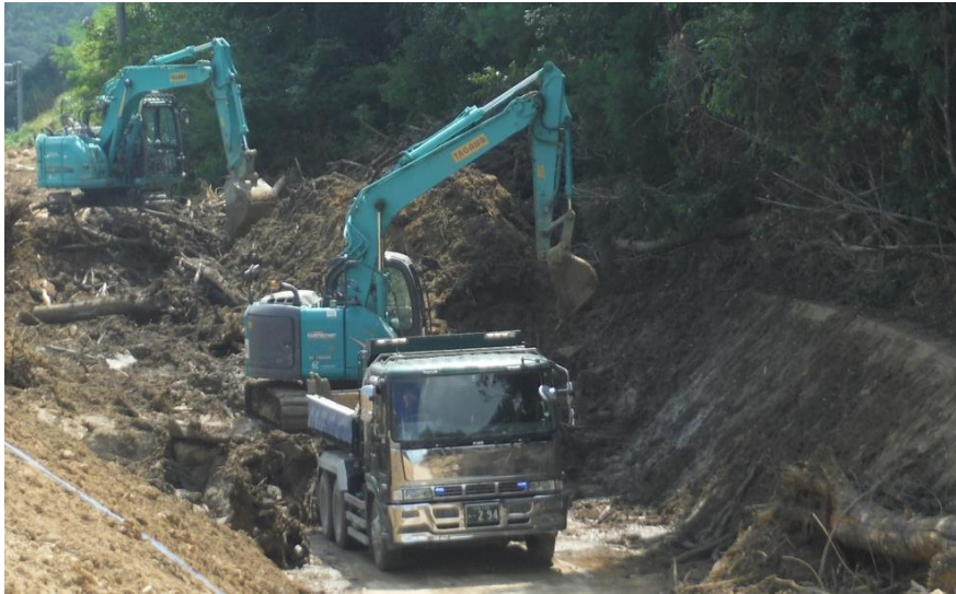
土砂撤去作業（東広島市高屋町）
