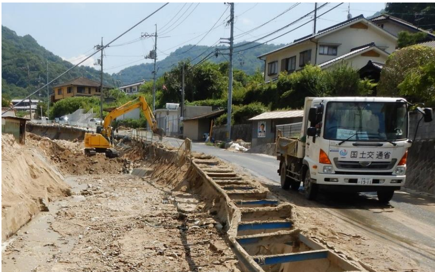
土砂撤去作業（坂町坂西）
