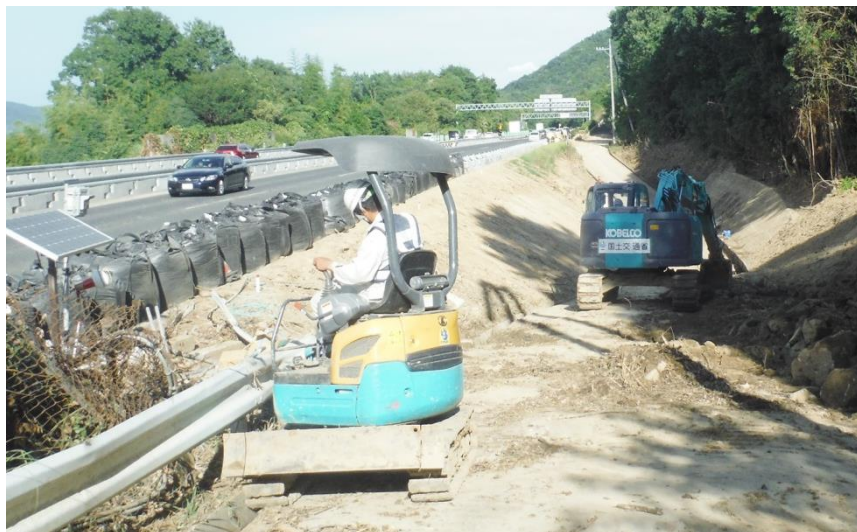
道路啓開作業（東広島市高屋町）
