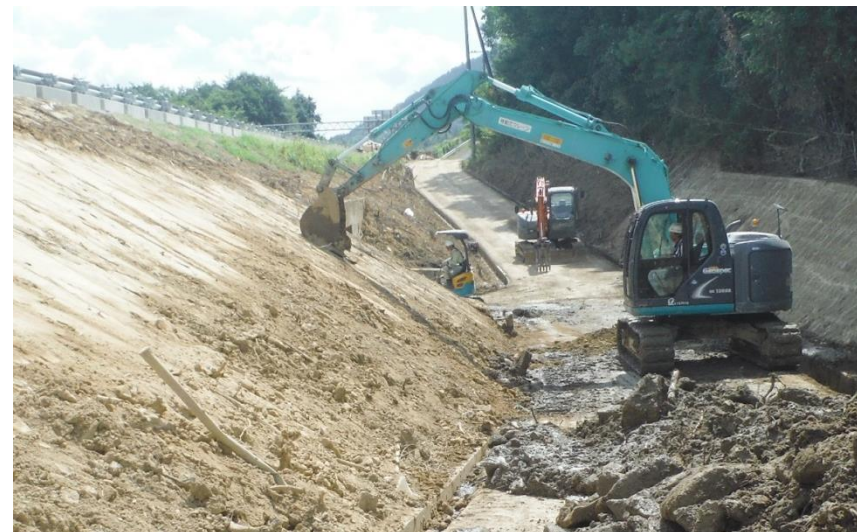
道路啓開作業（東広島高屋町）
