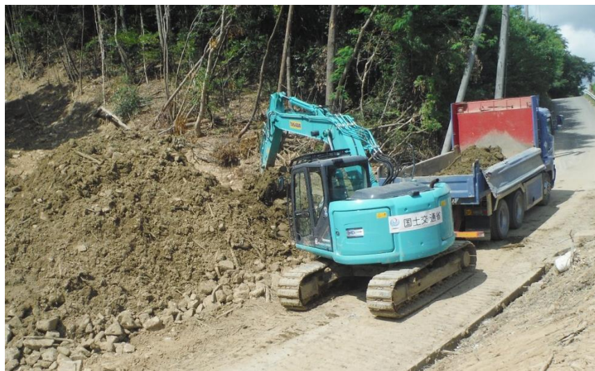
道路啓開作業（東広島市高屋町）
