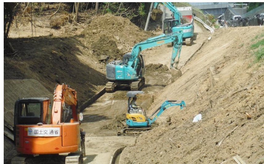
道路啓開作業（東広島高屋町）
