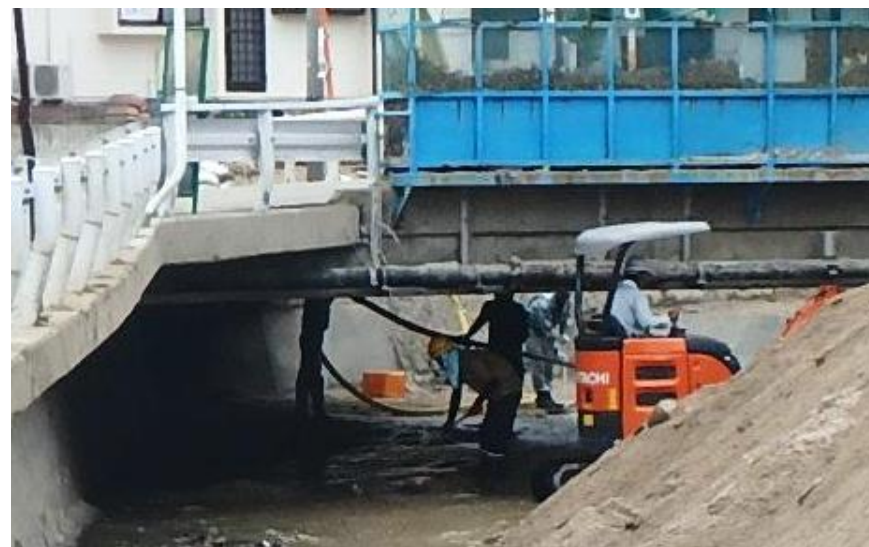
土砂撤去作業（坂町坂西）
