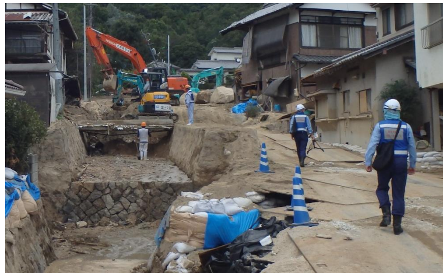
現地状況確認（呉市天応町）
