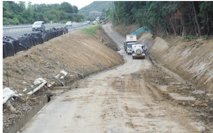
道路啓開作業（東広島市高屋町）
