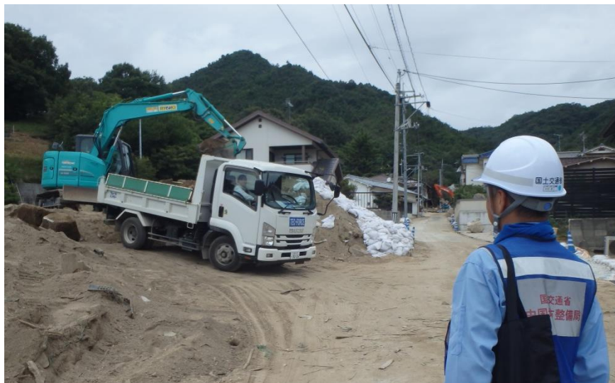
現地状況確認（呉市天応町）
