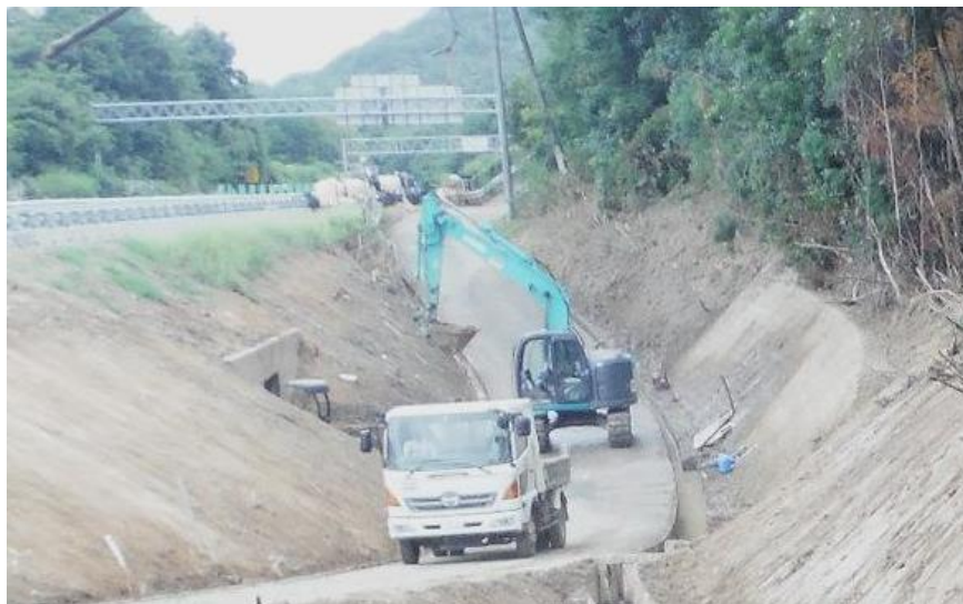
道路啓開作業（東広島市高屋町）
