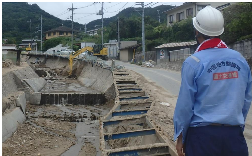
現地状況確認（坂町坂西）
