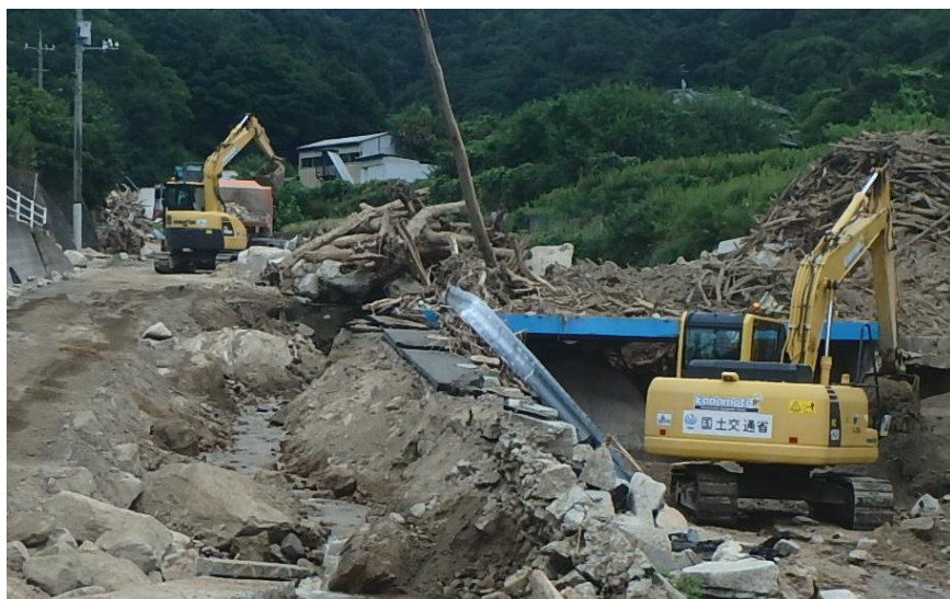
土砂撤去作業（坂町坂西）
