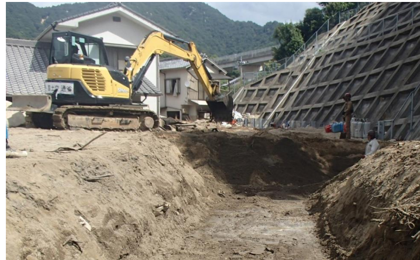
土砂撤去作業（坂町小屋浦）
