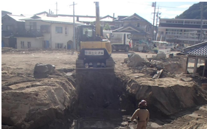
土砂撤去作業（坂町小屋浦）
