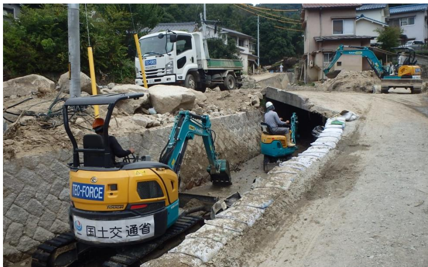
現地状況確認（呉市天応町）
