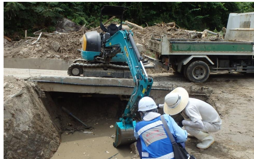
現地状況確認（呉市天応町）
