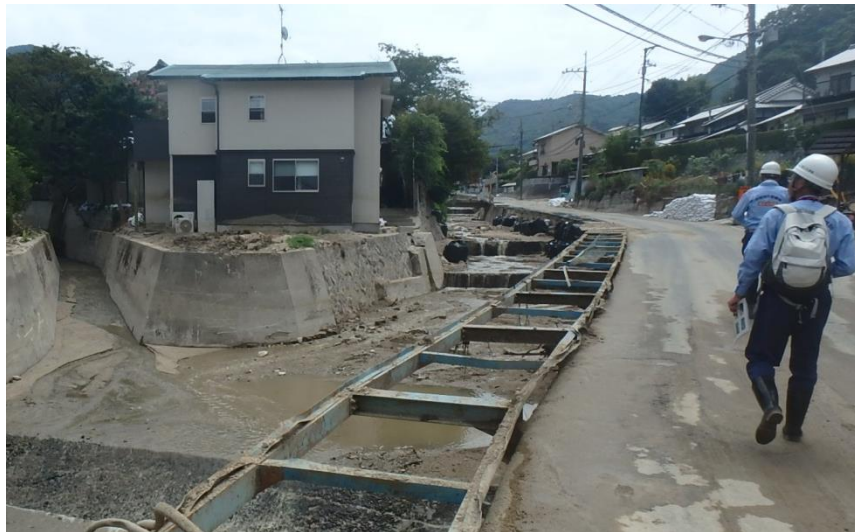
現地状況確認（坂町坂西）
