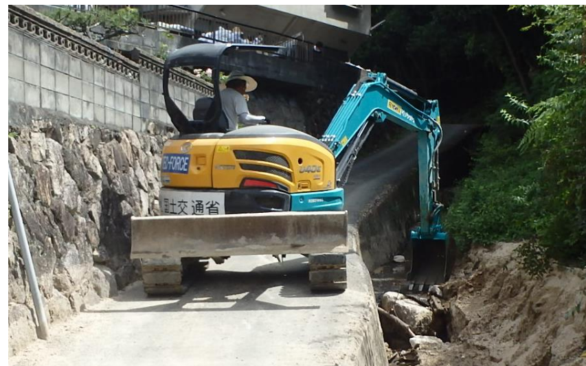
現地状況確認（呉市天応町）
