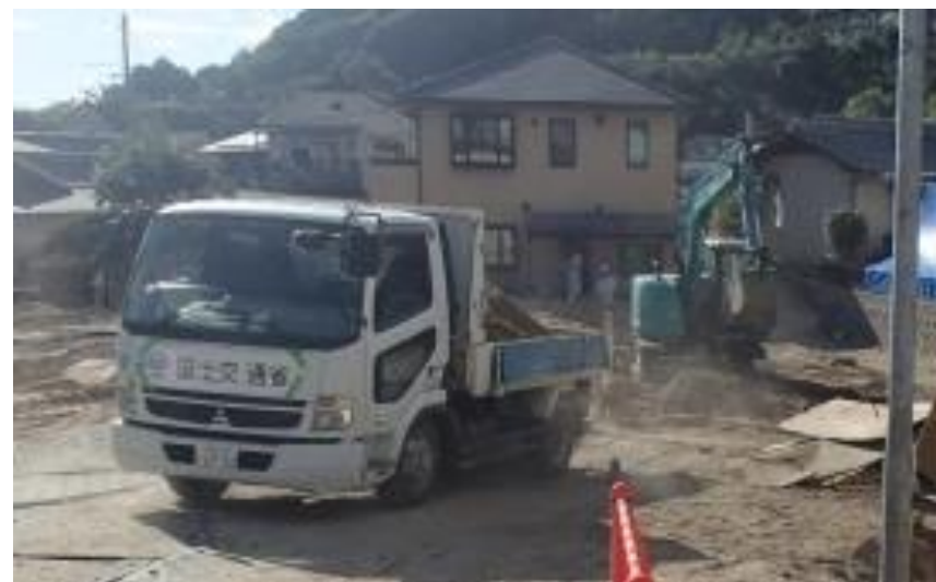
土砂撤去作業（坂町小屋浦）
