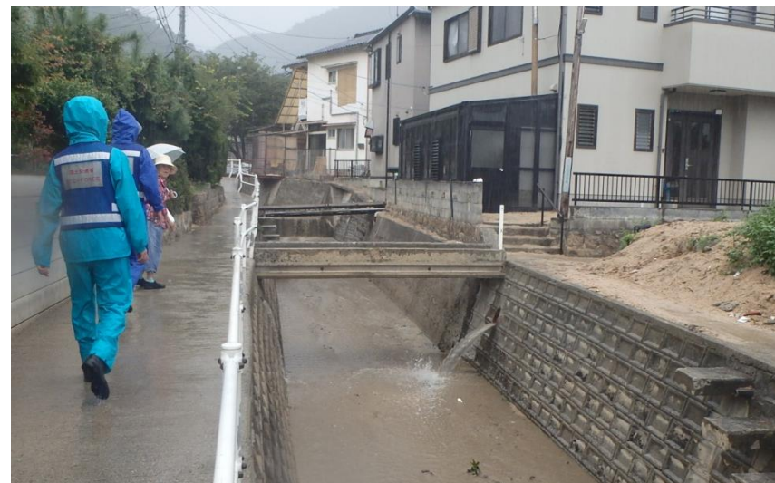
現地状況確認（呉市天応町）
