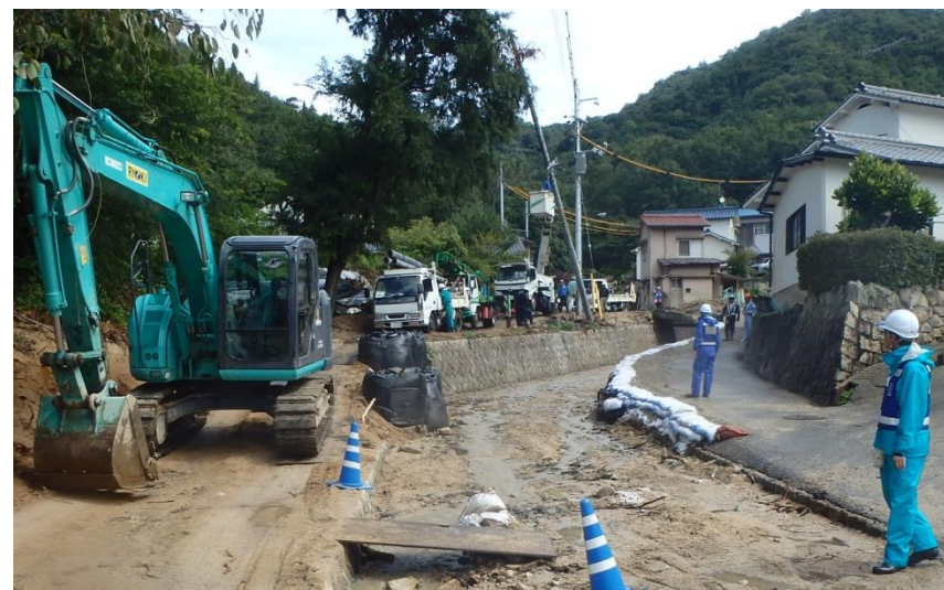
現地状況確認（呉市天応町）
