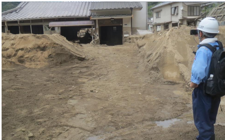
現地状況確認（坂町小屋浦）
