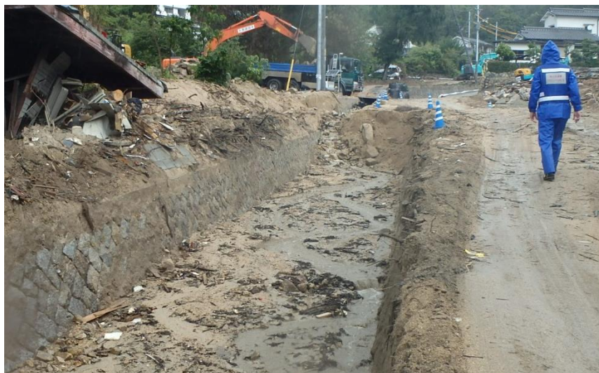
現地状況確認（呉市天応町）
