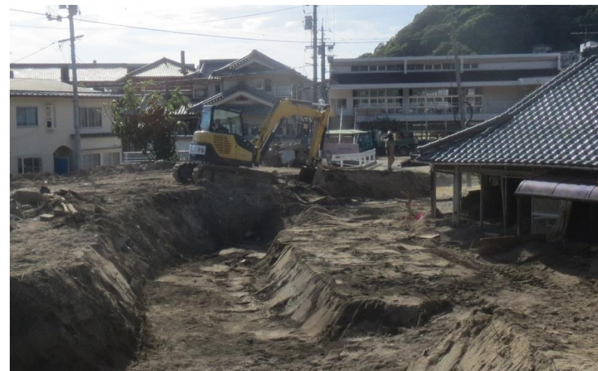
土砂撤去作業（坂町小屋浦）
