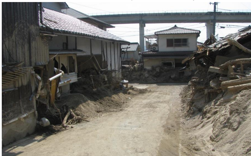
現地状況確認（坂町小屋浦）
