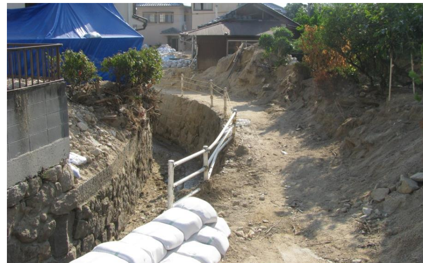
現地状況確認（坂町小屋浦）
