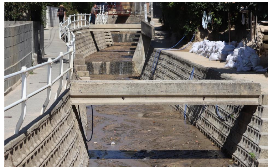
現地状況確認（坂町小屋浦）
