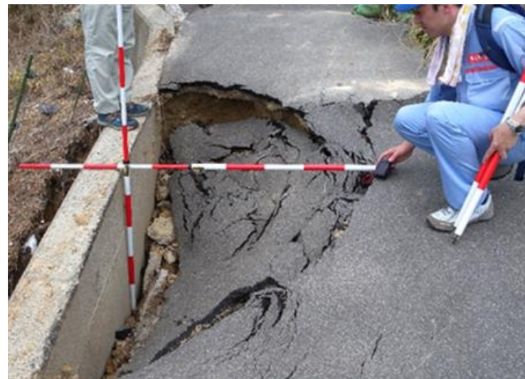
道路陥没箇所計測状況
