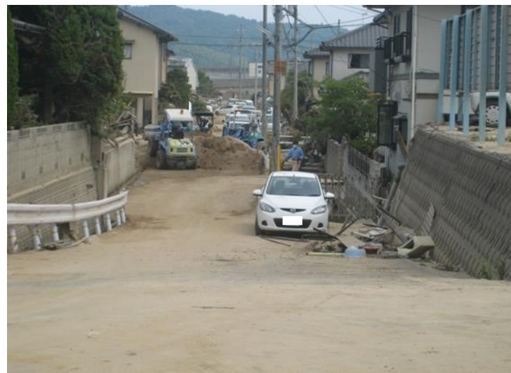
道路啓開状況
