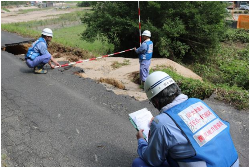
被災状況調査（高梁川）
