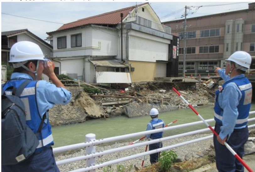
東広島市（ みつおがわ 三津大川）被災状況確認
