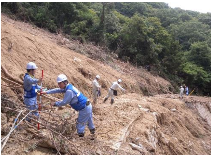
市道弥高線への土砂流入状況
