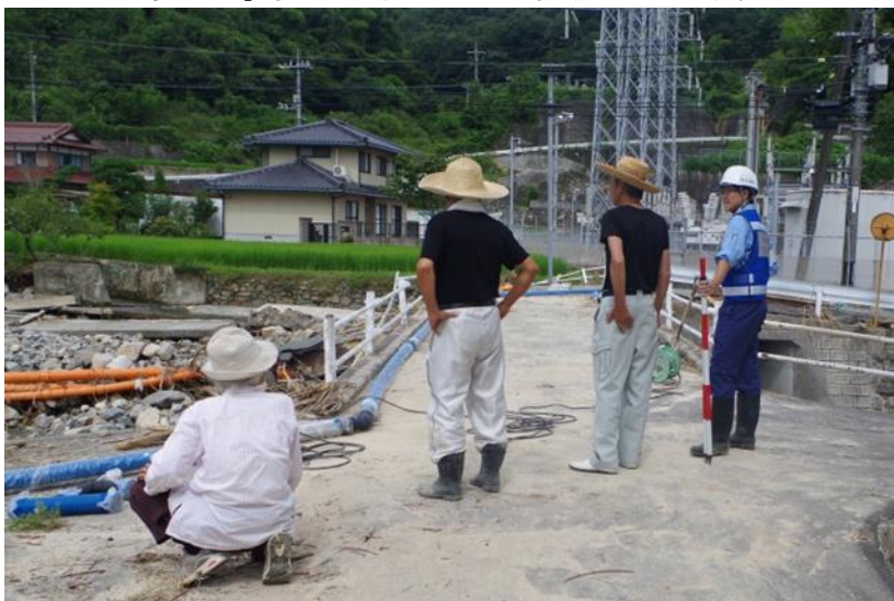
地域住民への被災状況説明
