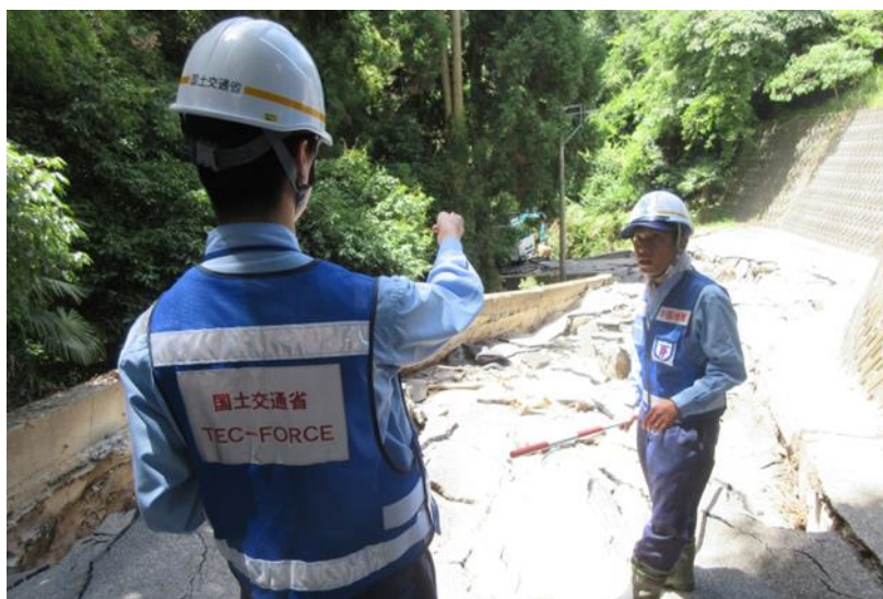
被災状況確認
