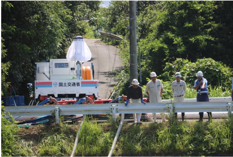
排水作業状況
