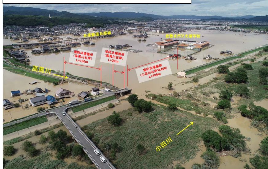
【H30.7豪雨】小田川左岸3.4k 堤防決壊状況
