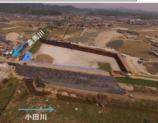
【H30.7豪雨】小田川左岸3.4k 堤防緊急対策実施状況
