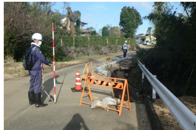
道路の被災状況を調査 (千葉県木更津市：道路班)
