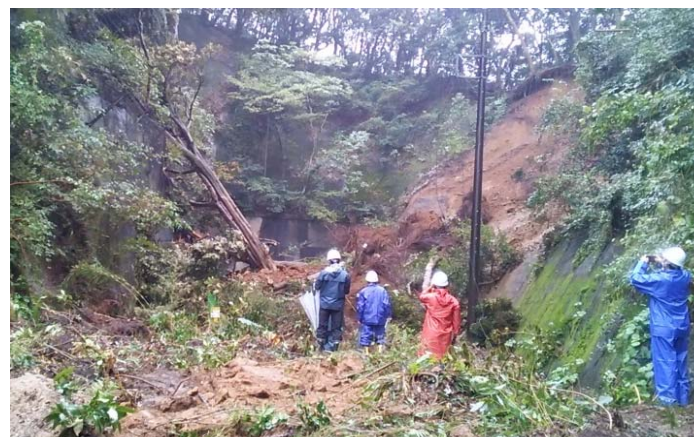
道路の被災状況を調査 （千葉県市原市）
