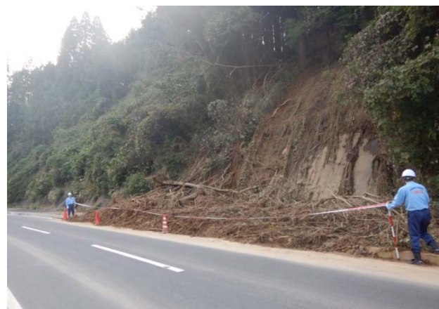
道路の被災状況を調査 (千葉県茂原市：道路班)
