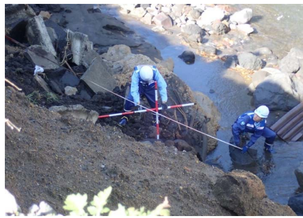
河川の被災状況を調査 (群馬県吾妻郡嬬恋村：河川班)
