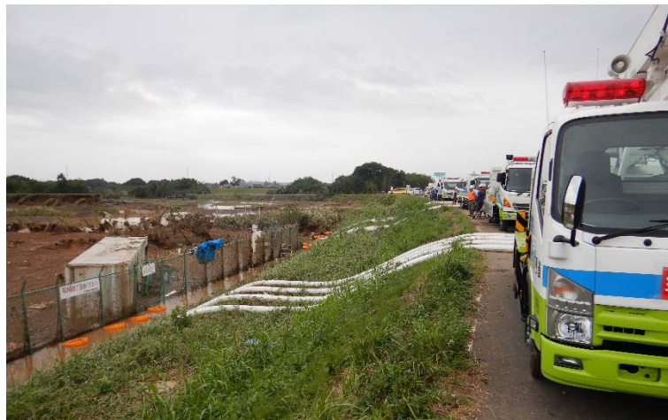
【埼玉県・越辺川】排水ポンプ車による排水作業（応急対策班）
