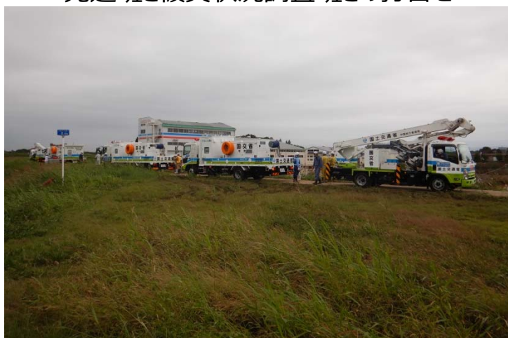
排水ポンプ車・照明車 排水作業準備中
