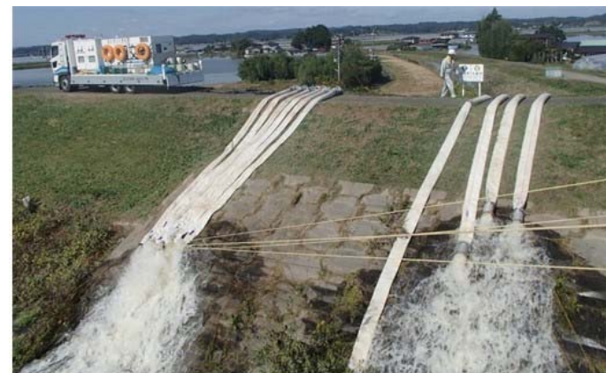
【宮城県・吉田川】排水ポンプ車による排水作業① (応急対策班)
