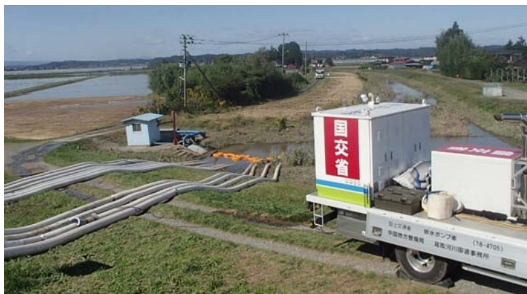
【宮城県・吉田川】排水ポンプ車による排水作業① (応急対策班)
