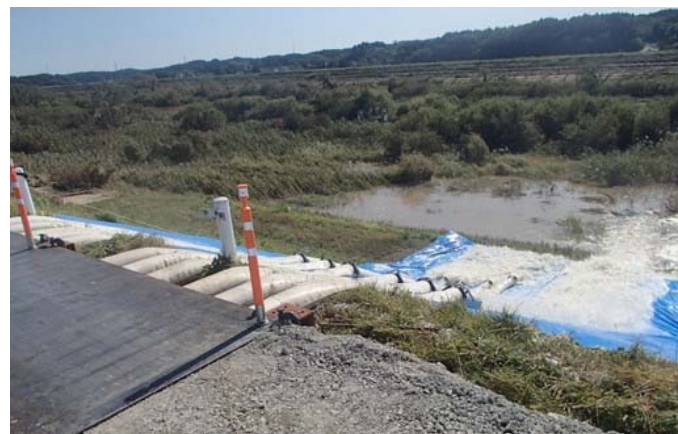
【宮城県・吉田川】排水ポンプ車による排水作業② (応急対策班)
