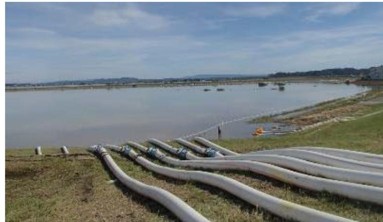
【宮城県・吉田川】排水ポンプ車による排水作業（応急対策班）
