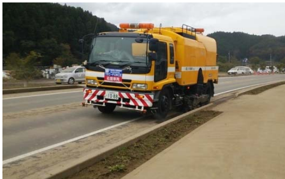
路面清掃車による道路清掃状況 (茨城県久慈市大子町：応急対策班)
