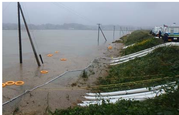
【宮城県大崎市】排水ポンプ車による排水作業 (応急対策班)
