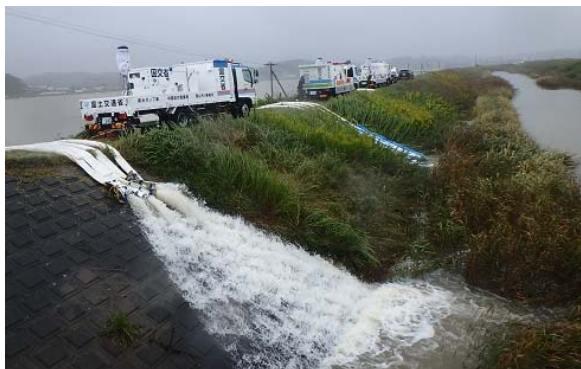
【宮城県大崎市】排水ポンプ車による排水作業 (応急対策班)
