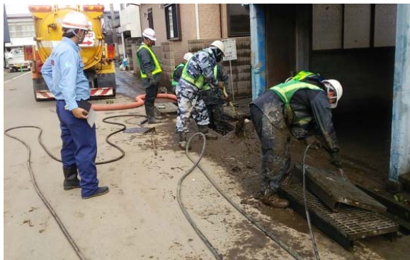
側溝の清掃状況 (茨城県：応急対策班)
