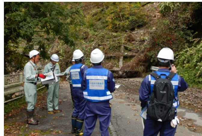
道路の被災状況を調査 (埼玉県秩父市：道路班)
