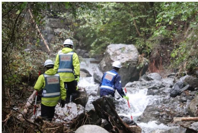
砂防の被災状況を調査 (埼玉県秩父市：砂防班)
