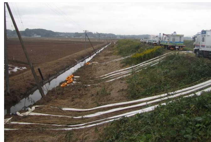
排水ポンプ車による排水作業 (宮城県大崎市：応急対策班)
