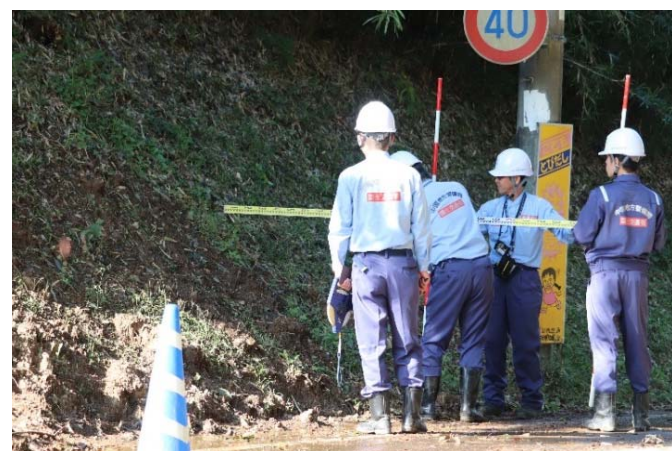
道路の被災状況を調査 (埼玉県東松山市：道路班)
