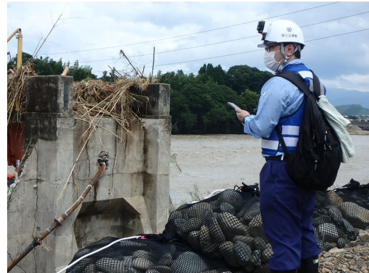
ウェアラブルカメラを活用した被災状況調査（熊本県人吉市）
