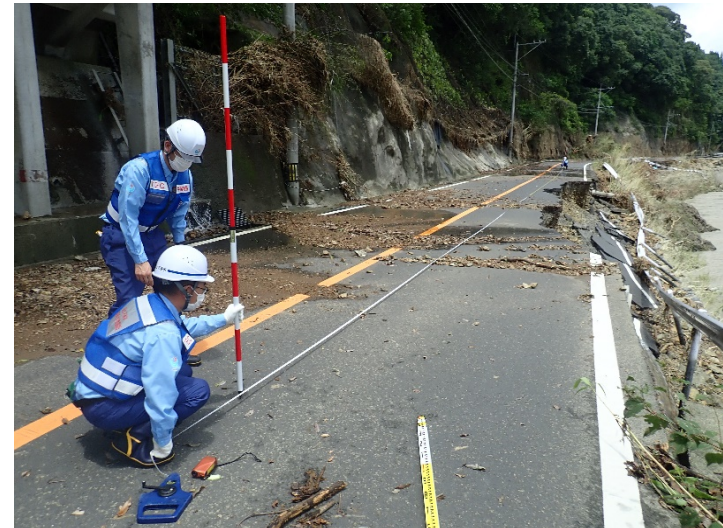
国道219号道路啓開調査（熊本県球磨郡球磨村）
