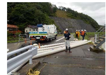
南田川排水樋門 4
