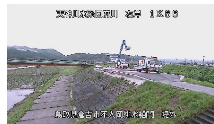
不入岡排水樋門
