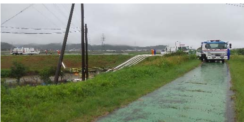
清水川排水機場
