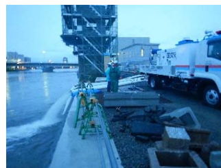
上追子排水機場
