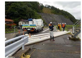
南田川排水樋門
