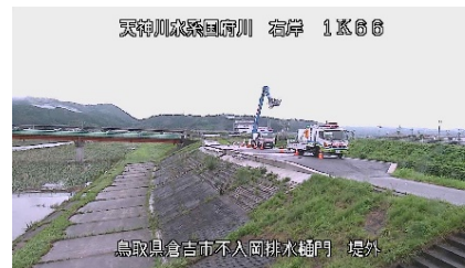
不入岡排水樋門
