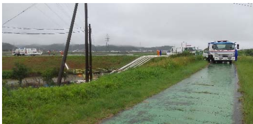
清水川排水機場
