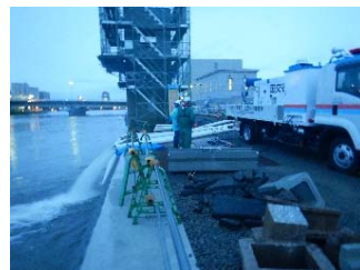
上追子排水機場
