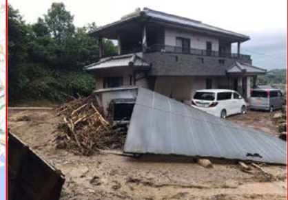
広島県三原市小泉(土石流) <家屋一部損壊1戸>
