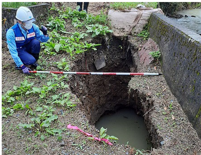
現地調査 (北広島町後有田) きたひろしまちょううしろありだ
