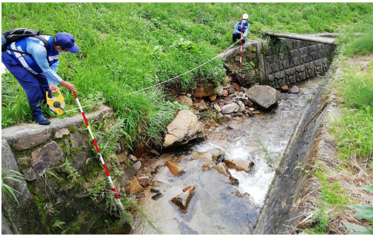
被災状況調査（河川②） きたひろしまちょうつしみ（北広島町都志見）
