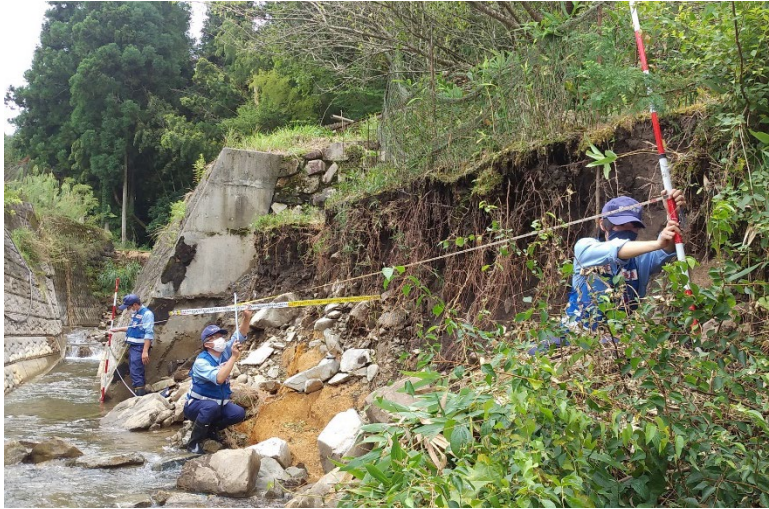
被災状況調査（河川①） きたひろしまちょうきつぎ（北広島町木次）
