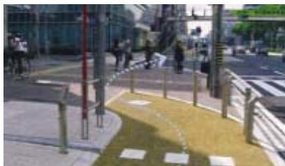
自転車の軌跡形状の配慮が不足しているシケイン形状(名古屋) (資料:自転車の走行性にあつた路面デザイン 徳島大学 山中英生)
