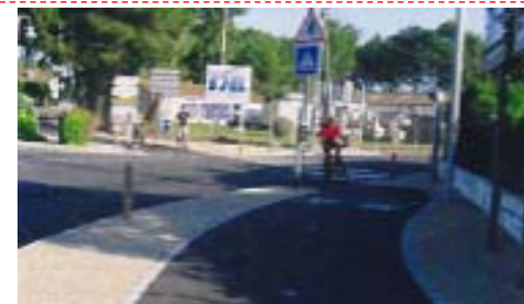
自転車の走行軌跡を思わせるシケイン形状(フランス) (資料:自転車の走行性にあつた路面デザイン 徳島大学 山中英生)
