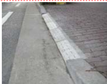
切り下げ部については、自転車が自転車歩行者道に乗り上げを考慮し、すり付けを実施。 (資料:自転車施策推進に係る地方説明会における疑義と回答事例集 国土交通省・警察庁)
