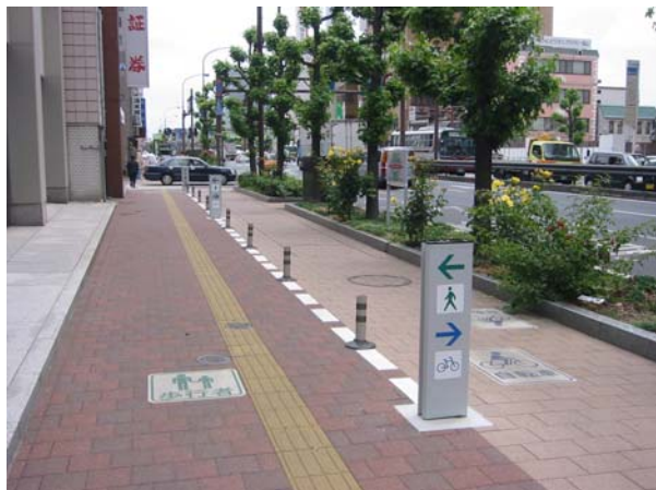
ボラード設置区間
