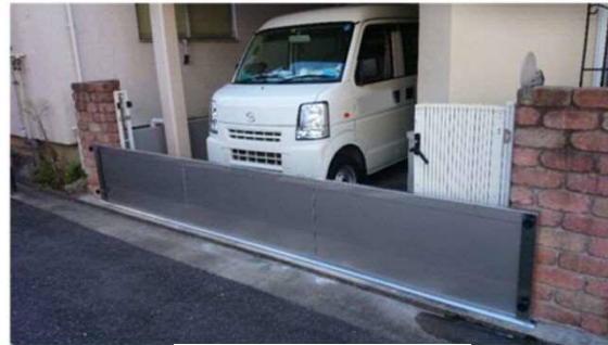
【止水板の設置例】
