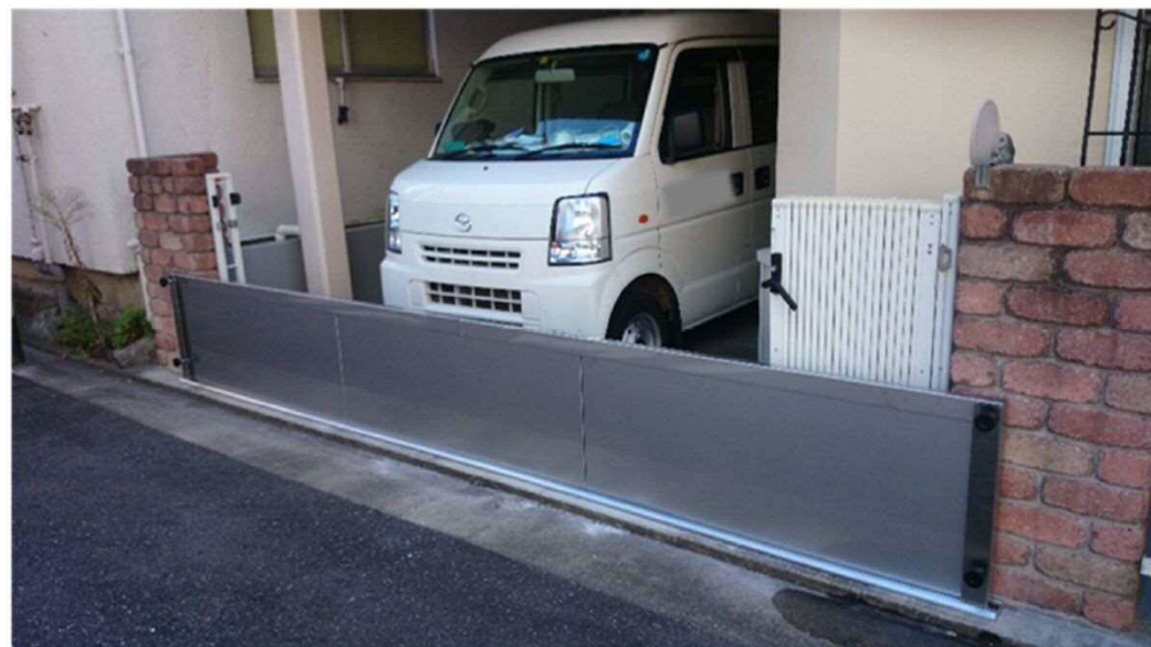
【止水板の設置例】
