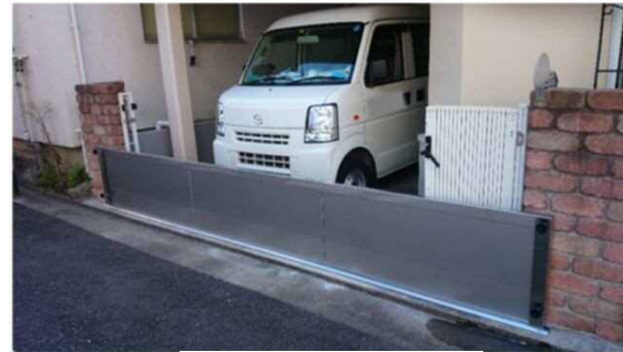
【止水板の設置例】
