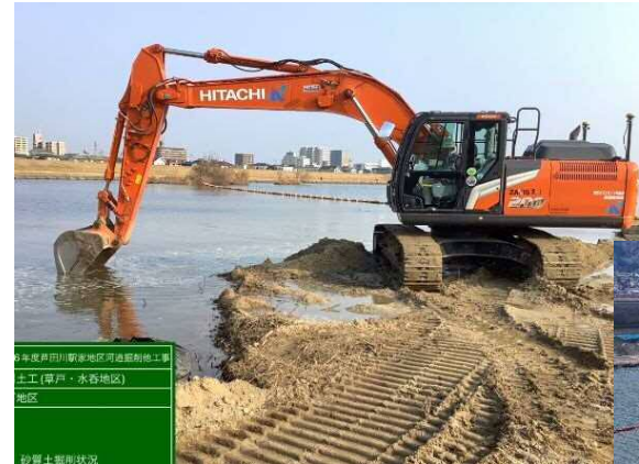
バックホウによる掘削状況
