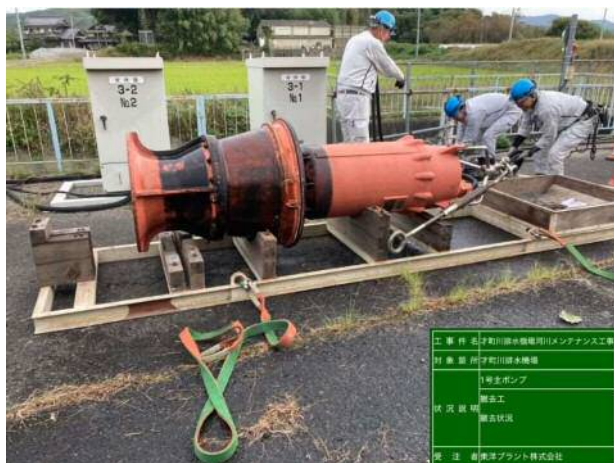
才町川排水ポンプ場1号主ポンプ更新（才町川）
