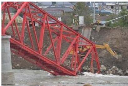
千曲川左岸側（上田）で崩落した別所線の鉄橋
