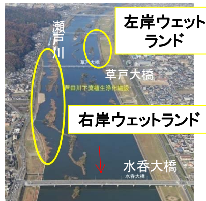
芦田川下流植生浄化施設
