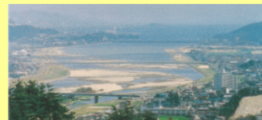
芦田川河口堰の枯渇状況
