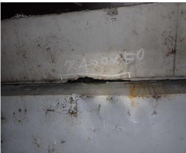
【損傷状況:床版のうき】
