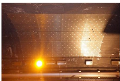
トンネル補修 （頂版部の剥落防止ネット設置）
