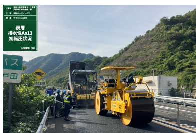
舗装修繕 （切削オーバーレイ工）
