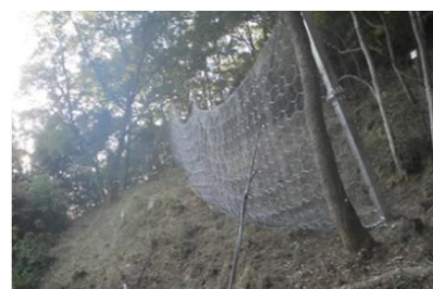
防災工事 （落石防止柵工）
