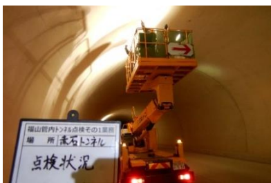
トンネル点検
