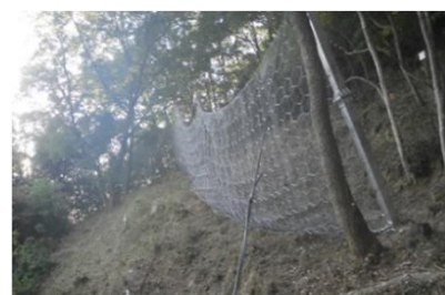
防災工事 (落石防止柵工)
