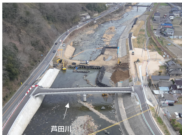
ちいし そうどの 父石・僧殿地区河川改修
