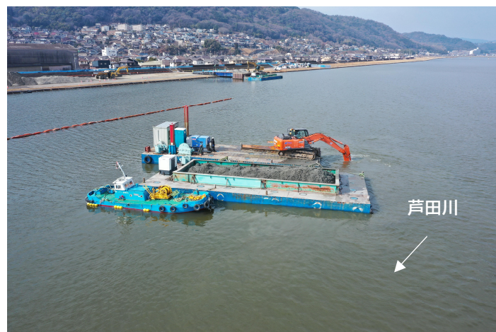
くさど みのみ 草戸・水呑地区河道掘削
