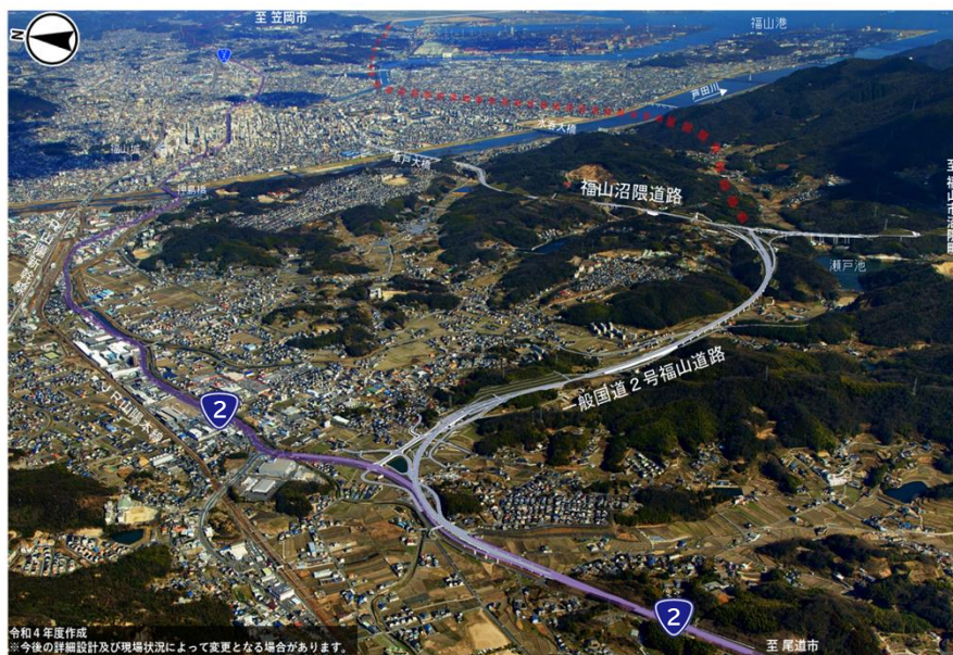
一般国道2号福山道路 終点部から福山市内方面を望む
