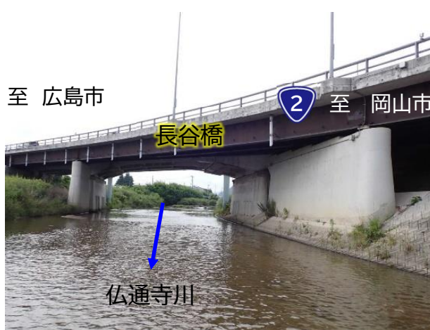
【側面】一般国道2号 河川交差
