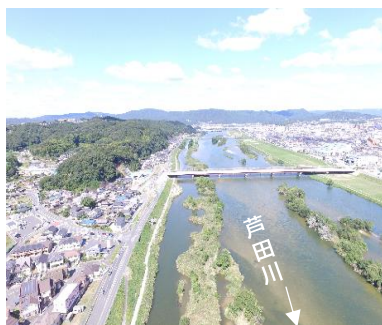
植生浄化施設
