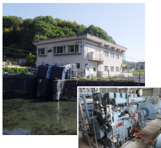
排水機場の長寿命化対策 かわみなみ (川南排水機場)
