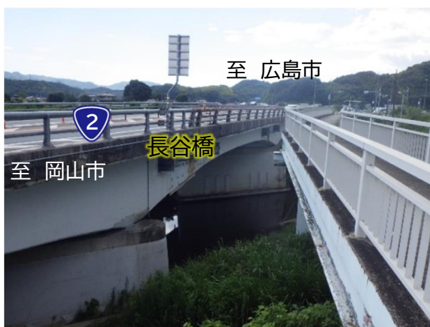
【側面全景】一般国道2号 長谷橋
