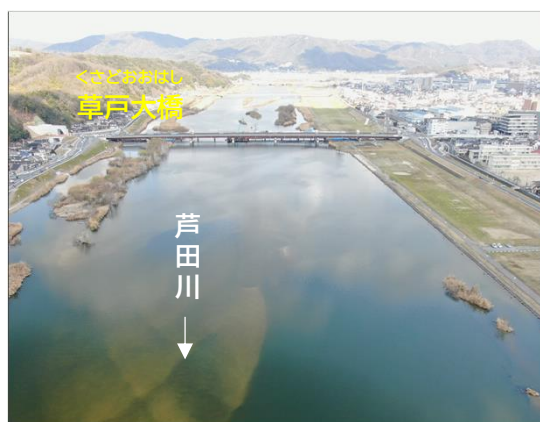
くさど みのみ 【掘削後】(草戸・水呑地区)
