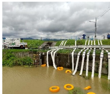
排水ポンプ車稼動状況
