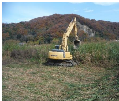
再繁茂抑制対策の例 (重機による幼木の踏み倒し)
