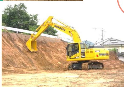
MC(マシンコントロール)自動コントロールシステムによる法面整形作業状況
