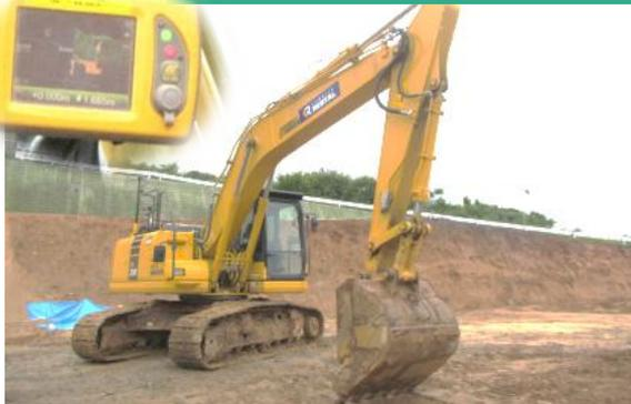
MG(マシンガイダンス) オペレートサポートシステムによる掘削作業状況
