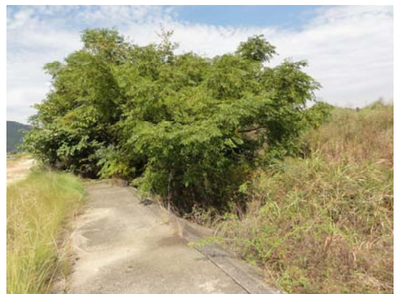
図 3-1-1 河道内樹木の状況
