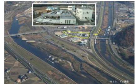
図 3-3-1 高屋川河川浄化施設
