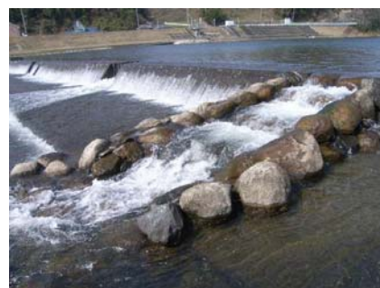
図 3-3-13 六地蔵用水堰の魚道
