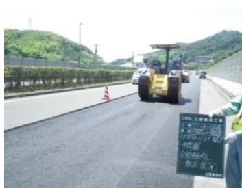
舗裝修繕 （切削オーバーレイ工）
