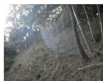
防災工事 （落石防止柵工）
