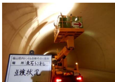
トンネル点検
