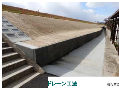
堤防浸透対策工法 （ドレーン工法）
