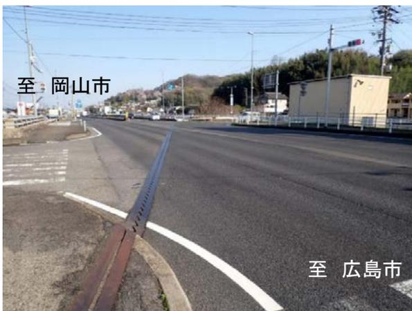
【損傷状況：伸縮装置劣化】
