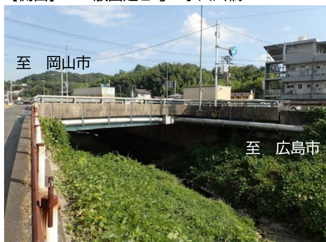
【側面】 一般国道2号 小田川橋
