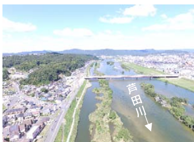
植生浄化施設
