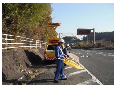
通常巡回（落下物処理）
