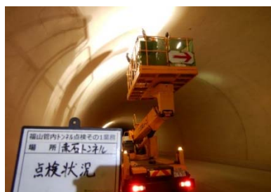
トンネル点検
