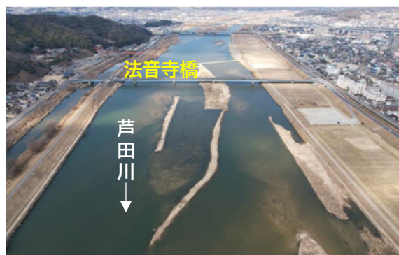
【掘削後】（草戸・水呑地区）
