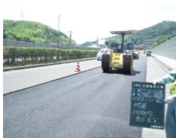
舗装修繕 （切削オーバーレイ工）
