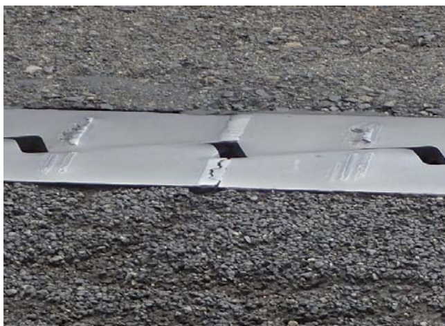
【損傷状況：伸縮装置劣化】
