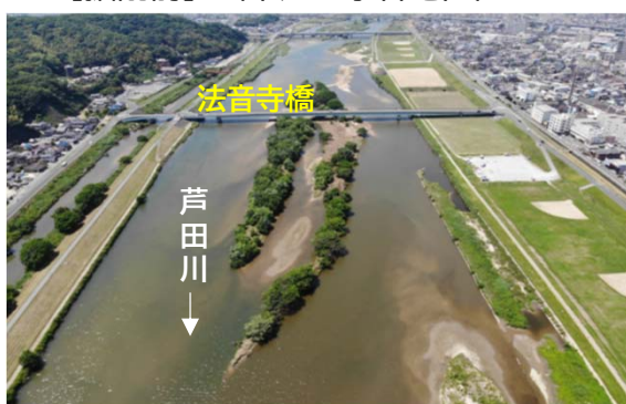
【掘削前】（草戸・水呑地区）
