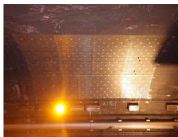
トンネル補修 （頂版部の剥落防止ネット設置）
