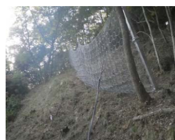
防災工事 （落石防止柵工）
