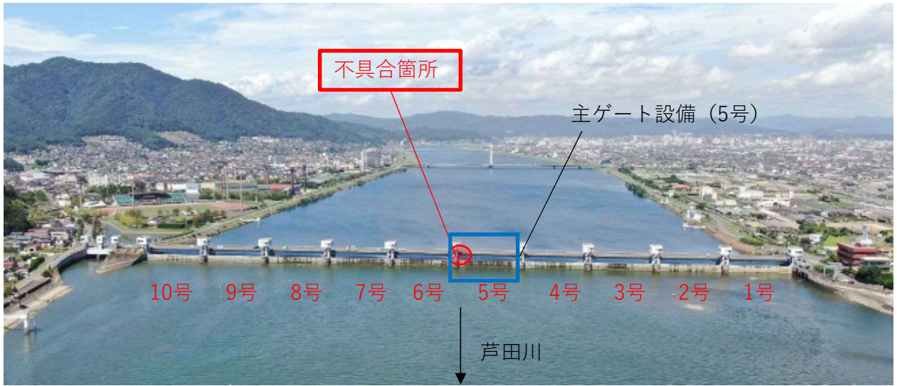
状況写真(令和元年9月16日 下流側から撮影)
