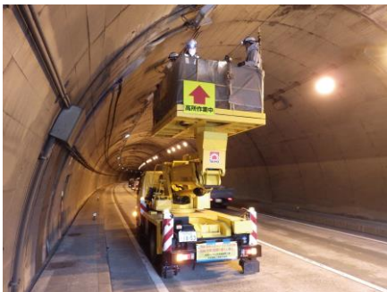
トンネル照明更新作業状況
