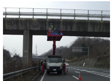
高架橋点検状況
