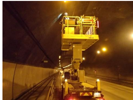
トンネル点検状況
