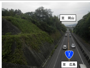
現状道路状況（宇根山橋より岡山方面を望む）
