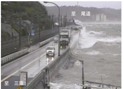
特殊通行規制区間が存在し、災害時には通行止めの可能性があり、道路が脆弱
