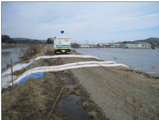
北上川河口部（宮城県石巻市）で 排水ポンプ車による排水状況
