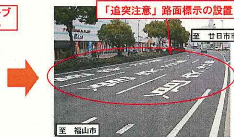
●整備後(右下欄に示す対策②)
