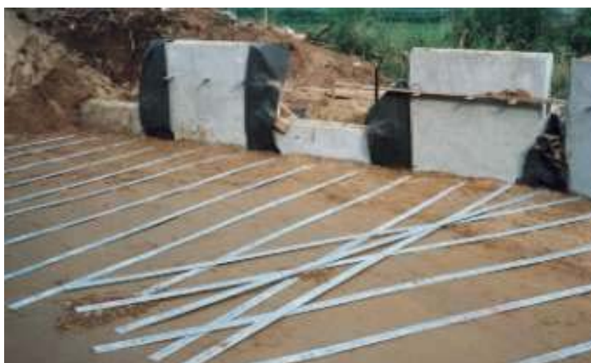
施工イメージ(写真)
