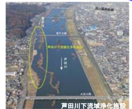
芦田川下流域浄化施設
