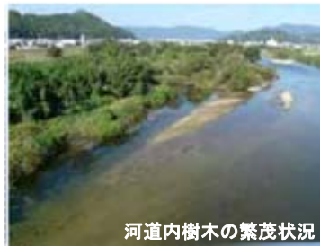
河道内樹木の繁茂状況
