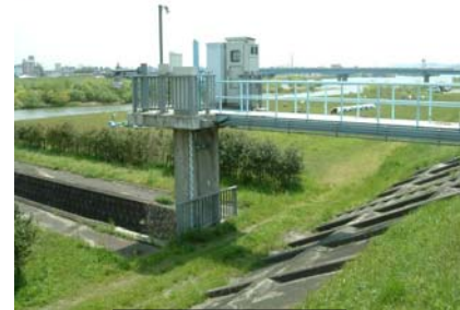
新涯排水樋門
