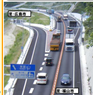
写真①: 三原バイパスの交通状況
