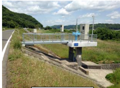
三光寺排水樋門
