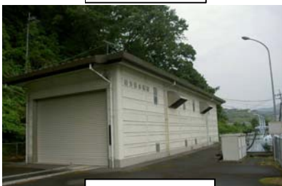
相方排水機場
