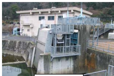
川南排水機場
