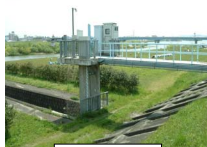
新涯排水樋門
